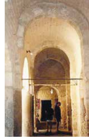
ضلع العقود النفقية في رباط سوسة التي بنيت عام 821م-822م
